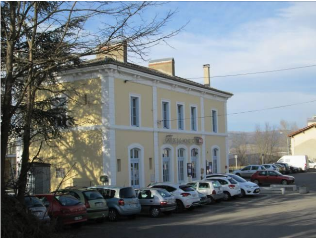
La gare ferroviaire de Bas / Monistrol
