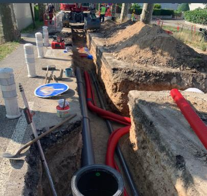
Les travaux d'enfouissement des réseaux secs et de renouvellement des réseaux humides en cours
