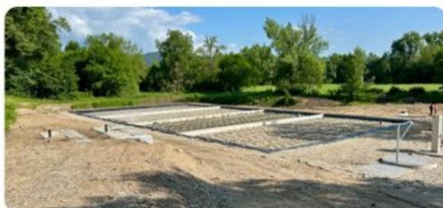
Le 2ème étage de traitement de la station d'épuration de Basset a été mise en service en avril dernier. Le traitement des eaux usées est maintenant conforme à la réglementation. Les travaux de finition sont en cours.
