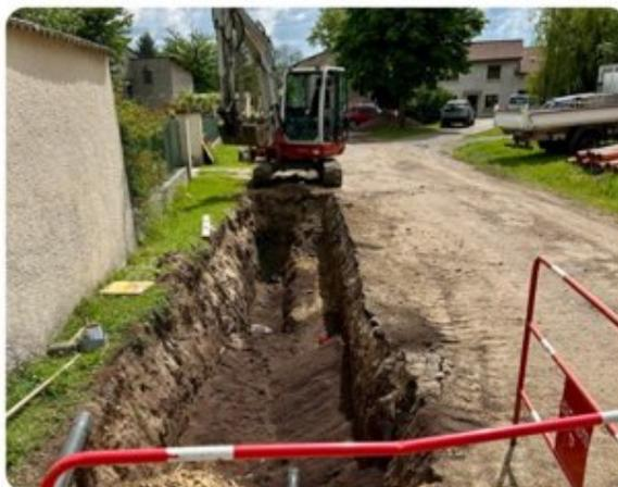
Les réseaux eaux usées, eaux pluviales, eau potable, sont en cours de réfection sur le secteur de la route des Bachats et du communal de Basset.
